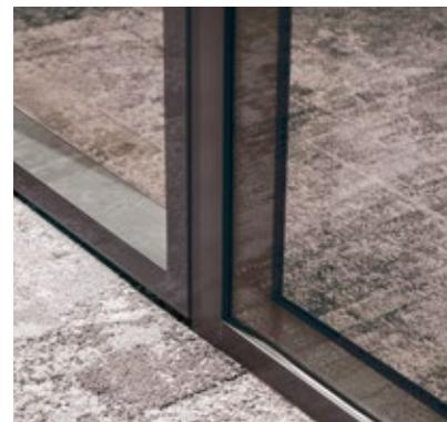
Die **Lehnertwand Vista DUO Doppelte Verglasung** mit hoher Stabilität, ganz ohne Stützen zwischen den einzelnen Scheiben. Dazu für eine Glaswand **hervorragende Schalldämmwerte**. Wandstarke Doppelglastüren machen das System komplett und sorgen auch im Türbereich für hohe Schalldämmung.
